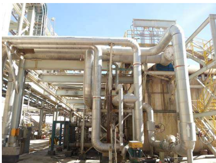
Fabricación de línea refluo 24'' inox 316L
